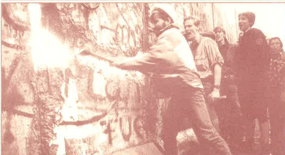
Confraternización de las dos Alemanias en el más que simbólico y hoy desaparecido Muro de Berlín.
